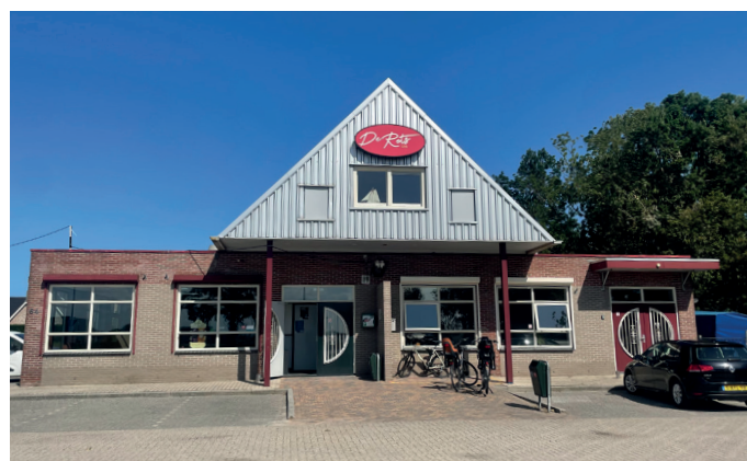
Gebouw De Rots
