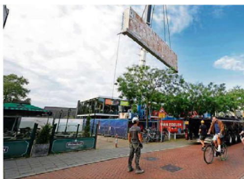
De eerste betonnen muur.
