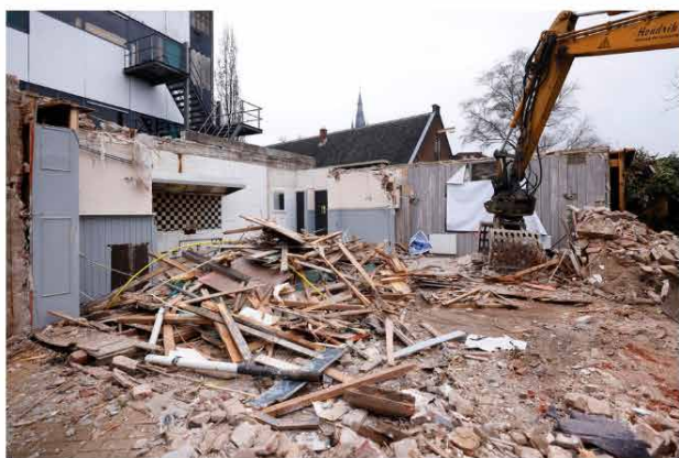
Van restaurant Nolleke is na een paar uur slopen al bijna niets meer over.
